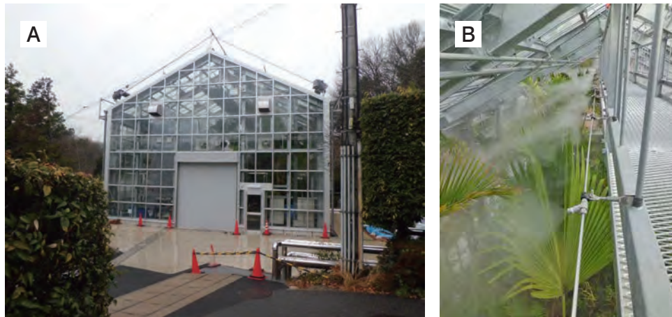
図3 新たに建設した保管温室 (A) と内部のミスト装置 (B)。
